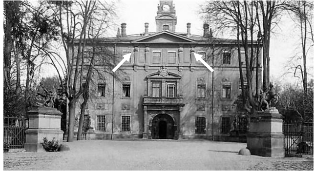
Auf dem Photo ist das im späten 19. Jh. aufgesetzte 2. OG zu sehen mit den Hermen-Pilastern aus Rochlitzer Porphy (Siehe Pfeile) (Sammlung Jörg Schlagowsky)
